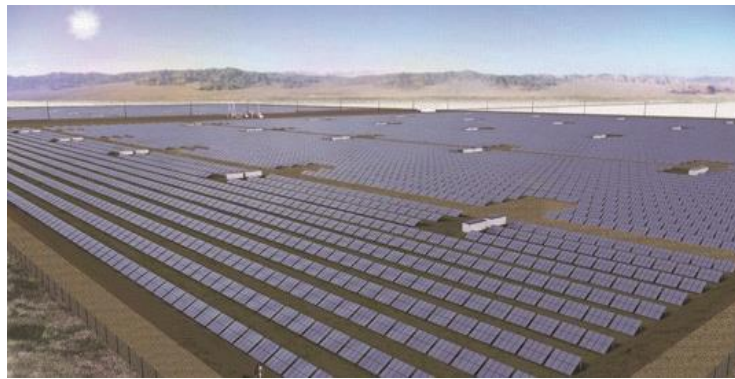
Gambar 2.2 Pembangkit Listrik Tenaga Surya
