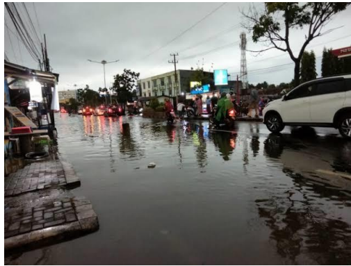
Gambar 1. 1 Kondisi Jalan Za. Pagar Alam, Nunyai saat banjir sumber : lampungpost(2022)
