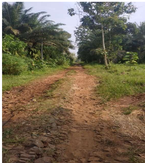
Gambar 2.1 Jalan Rusak di desa Sadar Sriwijaya
