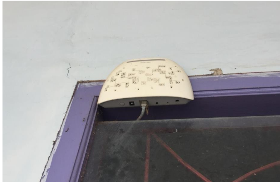
Gambar 3. 11 - Pemasangan akses point tambahan
